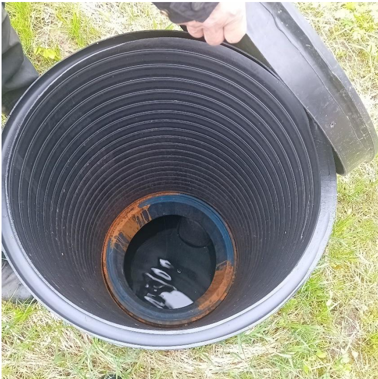
Joonis 6-13 Sihva reoveepuhasti pumbaga järelsetiti
