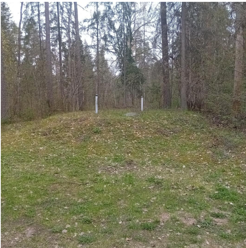
Joonis 5-1 Otepää Mäe veehaarde puurkaevpumppla ehitise tüüpvälisilme, konkreetselt pildil puurkaev nr 2, 8739
