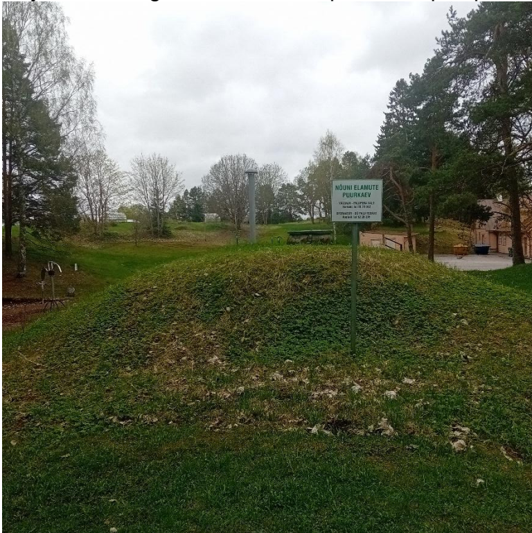
Joonis 5-14 Nõuni keskuse puurkaevpumpla välisilme
