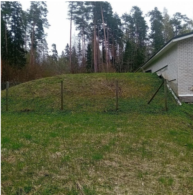
Joonis 5-3 Otepää veetöötus ja pumplahoonest vasakule jääv mahuti on toorveemahuti
