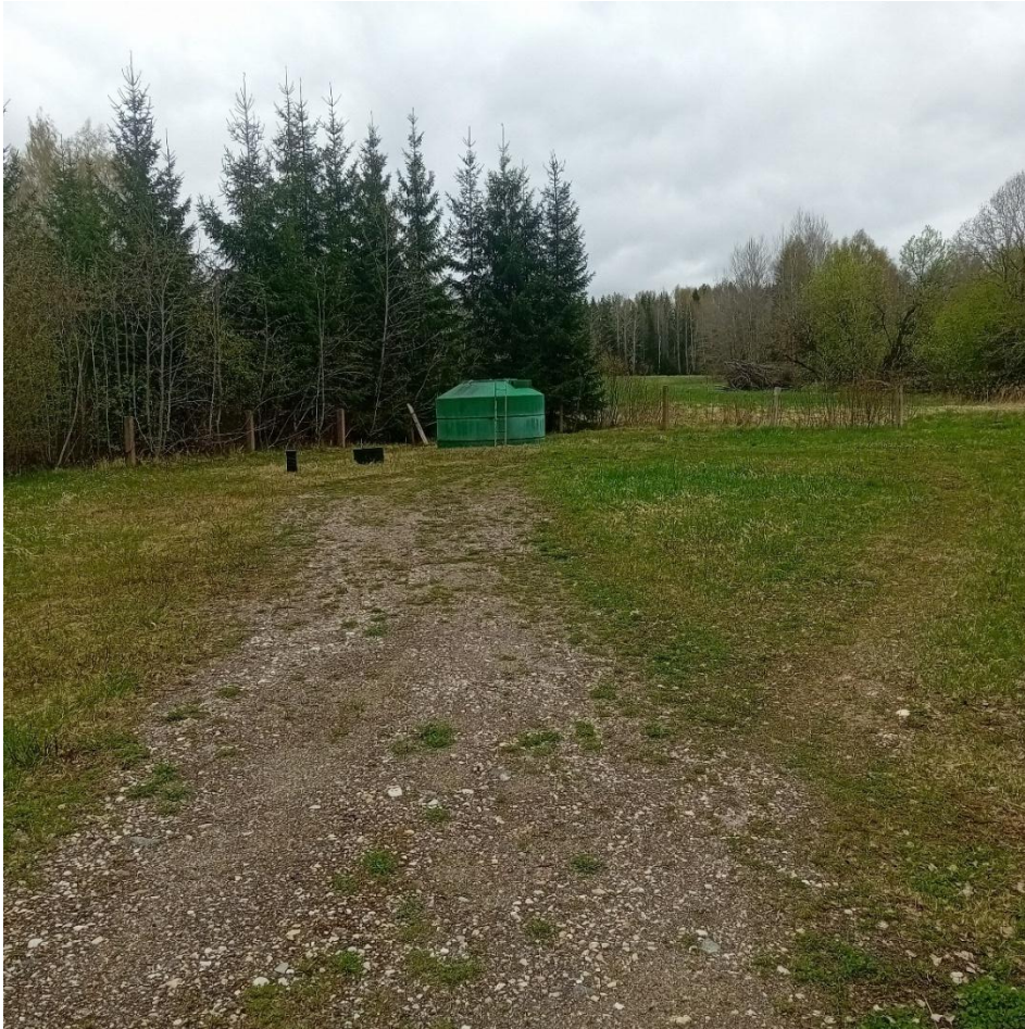
Joonis 6-14 Nõuni reoveepuhasti mittetöötav nõrgbiofilter ja selle taga asuvad biotiigid
