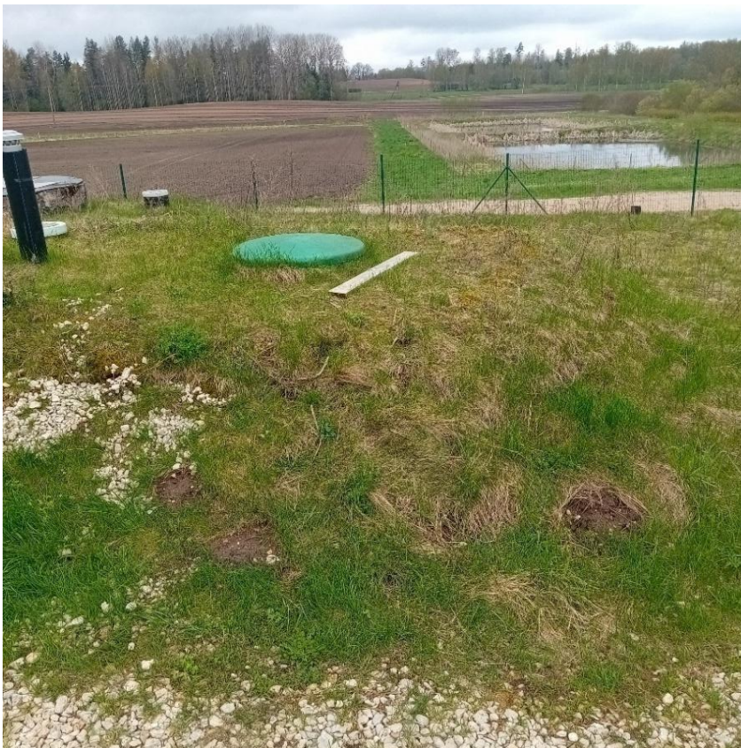
Joonis 6-8 Puka (Pukamõisa) reoveepuhasti 1. biotiik
