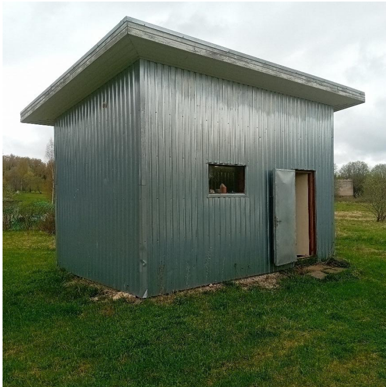
Joonis 5-4 Pühajärve puurkaevpumpla ja veetöötusjaama välisilme
