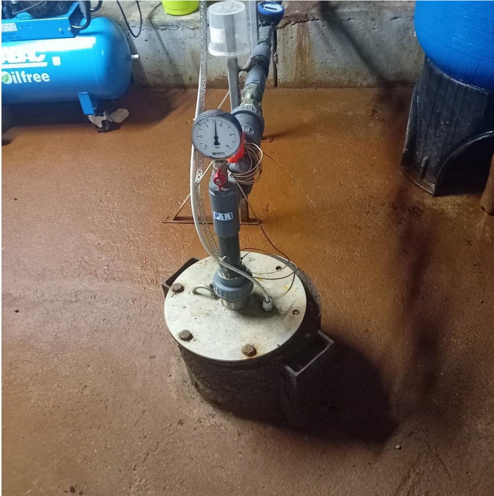
Joonis 5-11 Keeni Keskuse puurkaevpumpla sisevaade. Puurkaevu päis
