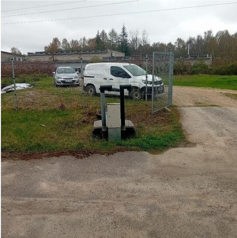
Joonis 6-4 Otepää Alajaama reoveepuhasti eelne reovee peapumpla
