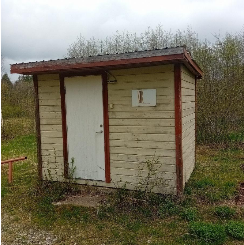
Joonis 6-10 Keeni reoveepuhasti tehnohoone
