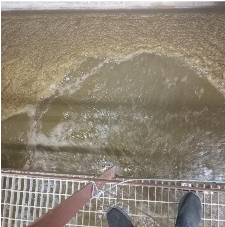
Joonis 6-5 Otepää alajaama reoveepuhasti aerotank
