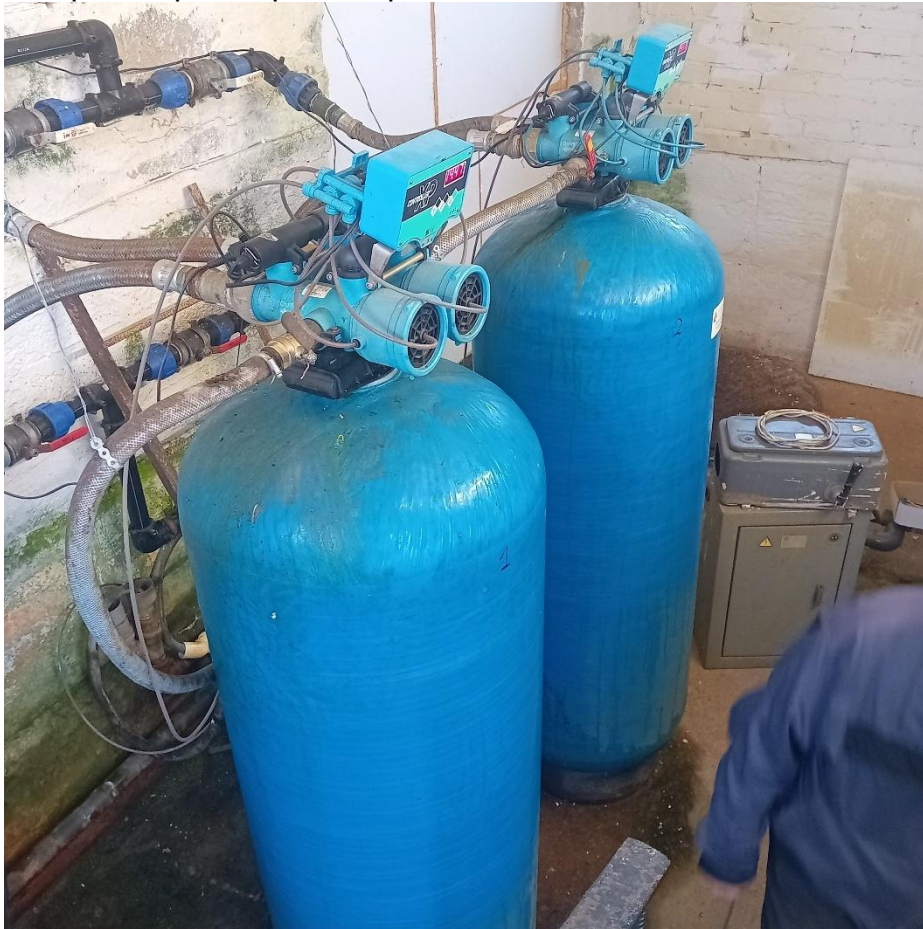
Joonis 5-13 Sihva (Voki) puurkaevpumpla sisevaade (paarisfilter)
