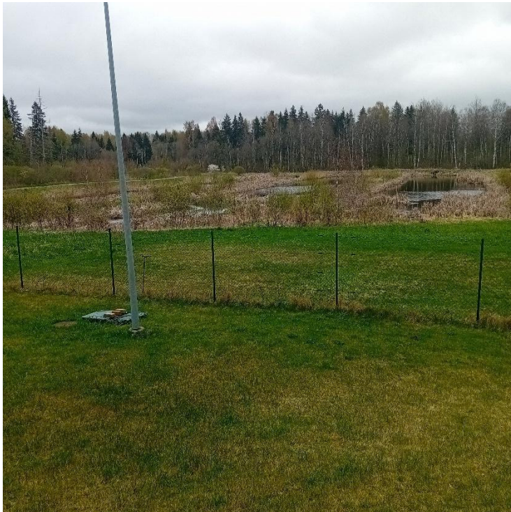
Joonis 6-3 Otepää reoveepuhasti serpentiin-biotiigid
