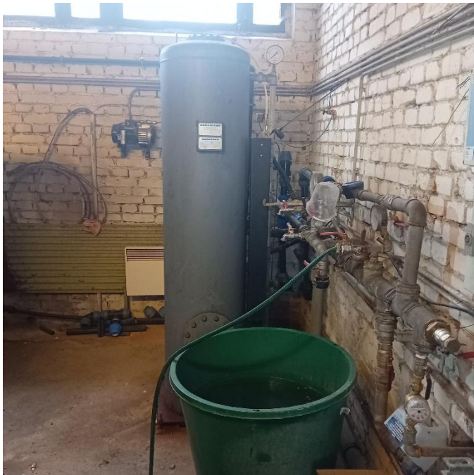
Joonis 5-16 Lossiküla pumpla veetöötlusfilter
