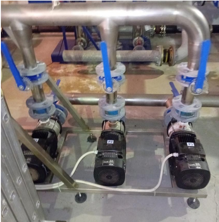
Joonis 5-2 Otepää Mäe veehaardekompleksi pumplahoone sisevaade (survetõstepumpade üks komplektidest)
