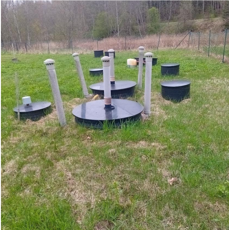
Joonis 6-12 Sihva reoveepuhasti välisvaade, esiplaanil anaeroobne eelsetiti ja biofilter
