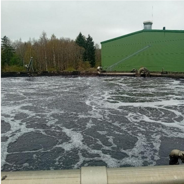
Joonis 6-1 Otepää reoveepuhasti SBR mahuti
