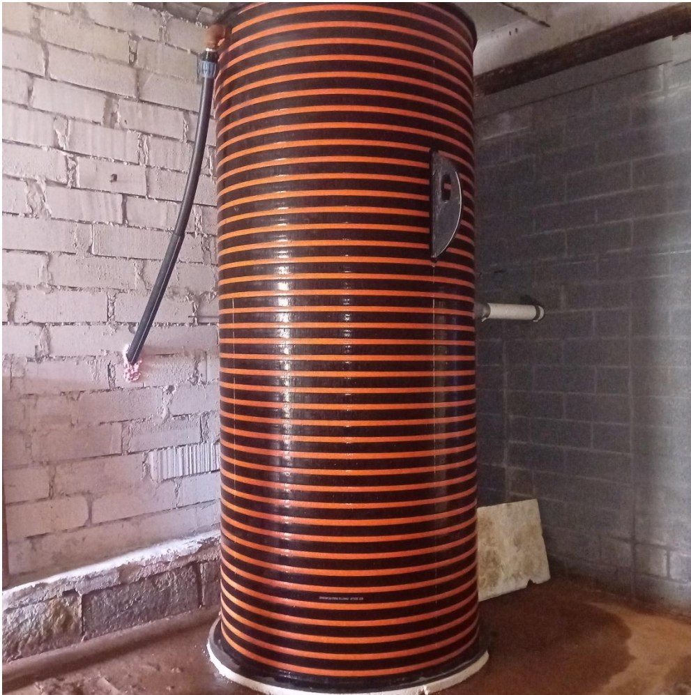
Joonis 5-12 Keeni Keskuse puurkaevpumpla uus puhtaveereservuaar
