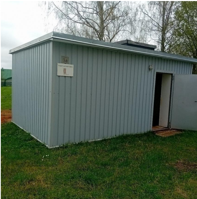
Joonis 5-5 Puka Ääre tn pumplahoone välisilme
